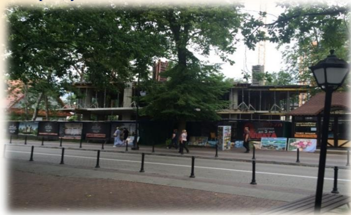
Строительство здания торгово-рекреационного комплекса, ул. Ленина, 52.
