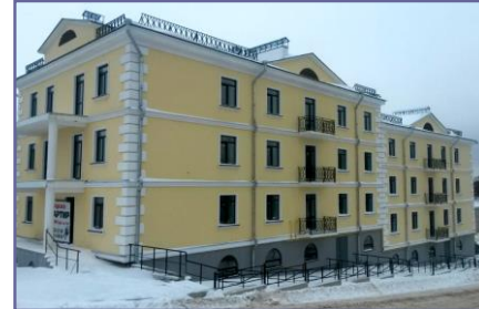
Строительство многоквартирных жилых домов более 300 млн.руб.
